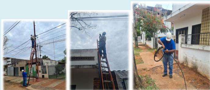
El suministro intervenido se identifica con el NIS 2850032, donde fue constatada una "Conexión directa sin medidor" con conductores de 4x6 milímetros (fase + neutro) con cargas de 9,8 - 9,7 y 0,1 amperes en cada fase, al momento de la intervención, según el Informe Técnico de Verificación N° 66593 y Notificación N° 42701.
